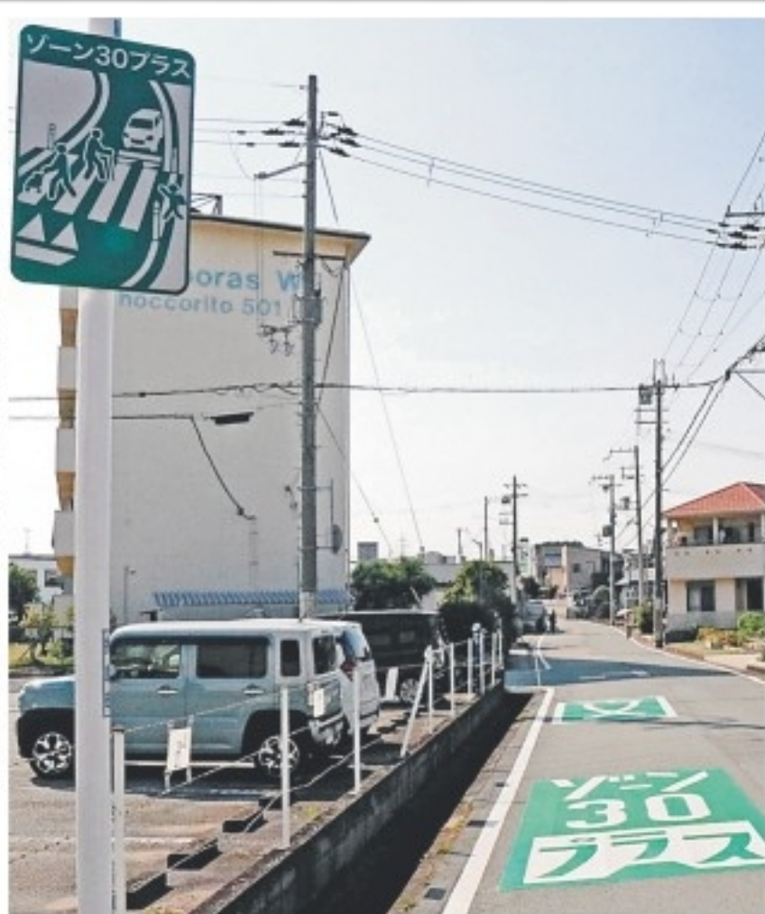
「ゾーン30プラス」のエリアであることを示す標識や路面標示＝播磨町北本荘1
